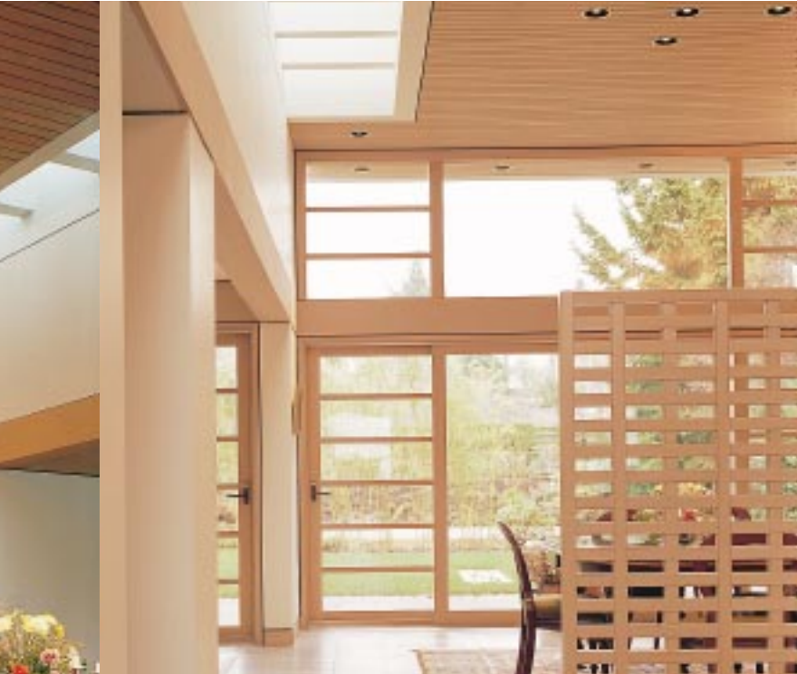
左・上 / 淡い色調のダグラス・ファーを使用して、天井板、窓枠、パーティションなどに統一して使用した例。
