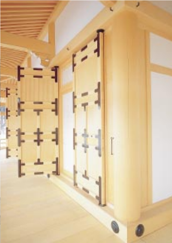
上 / 木目が緻密で収縮性も小さく、寸法安定性が極めて高いため、外気にさらされるような厳しい使用条件下でも優れた耐久性を発揮します。
