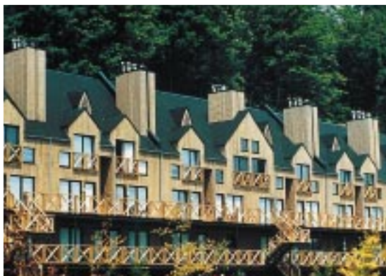
上 / 日本最大の木造建築物として建築されたマハリシ総合研究所那須センター。古代建築学の原理を採用して建てられ、その部材にウェスタン・レッド・シダーが使用されました。
