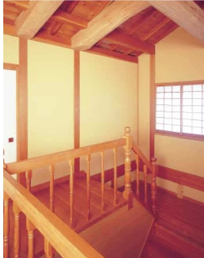
右 / 耐摩耗性にも優れているため、階段の踏み板や床材としてもよく使用されます。
