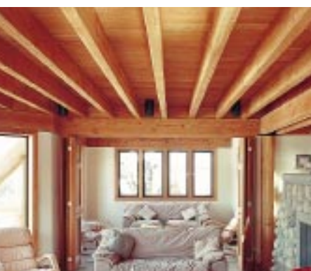
上 / 躯体部分を意匠的に仕上げ面に露出させた事例。山小屋風のデザインは、やすらぎとともに安定感をあたえてくれます。
