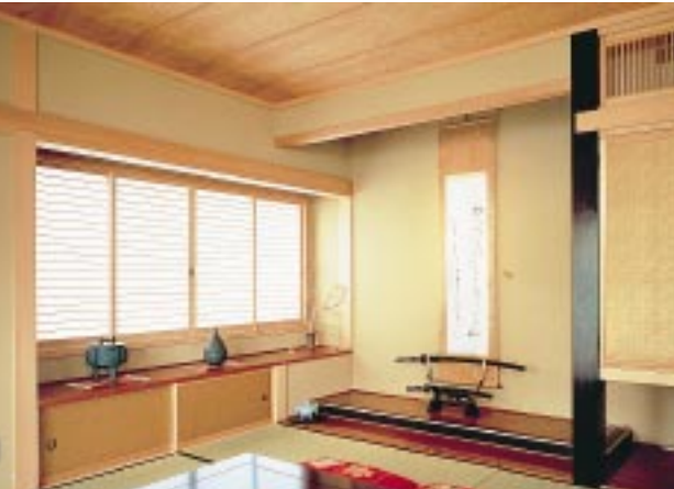
下 / 構造材として使用しているカナディアン・ヘム・ファーの一部を意図的に表面に露出させて仕上げた事例。
