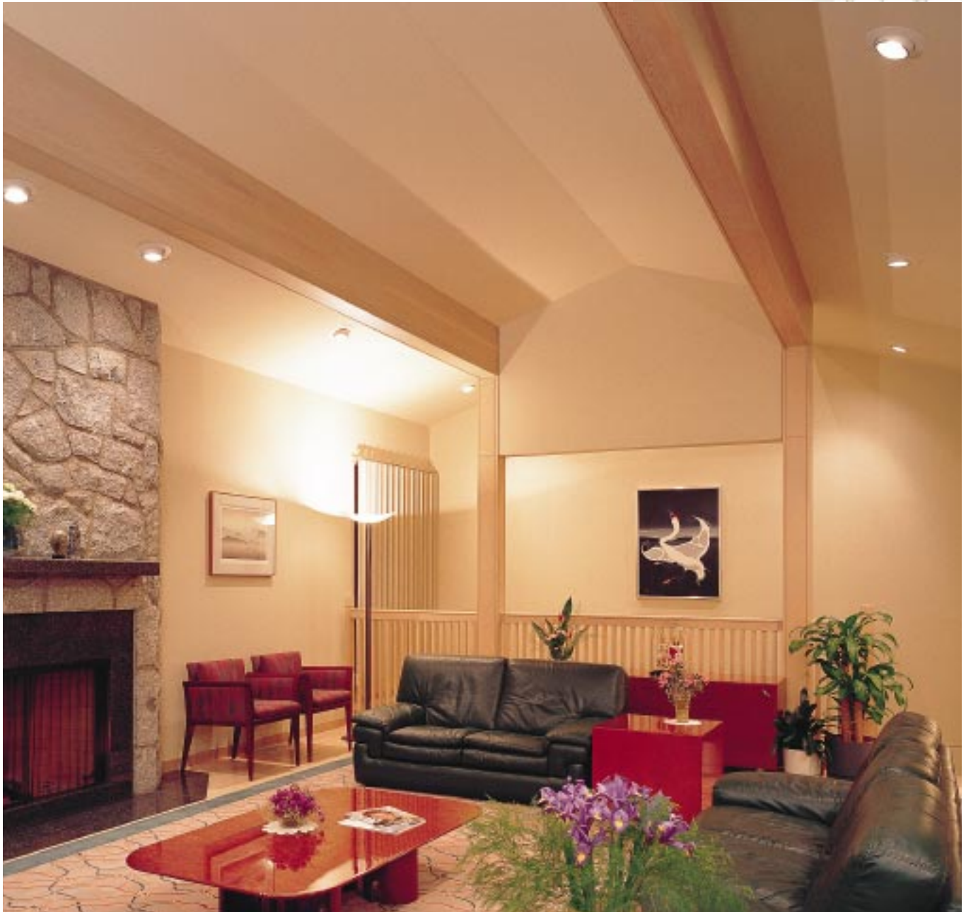
下 / 構造材として使用しているカナディアン・ヘム・ファーの一部を意図的に表面に露出させて仕上げた事例。
