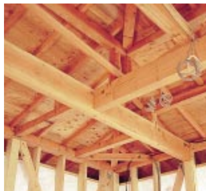
下 / 強度特性を最も有効に活用しているのが、梁、胴差し。ヘビーティンバー工法の大断面部材などとしても使用されています。
