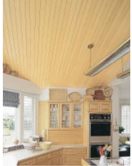
上2点 / 壁や天井など室内のパネル材として使用された事例。
