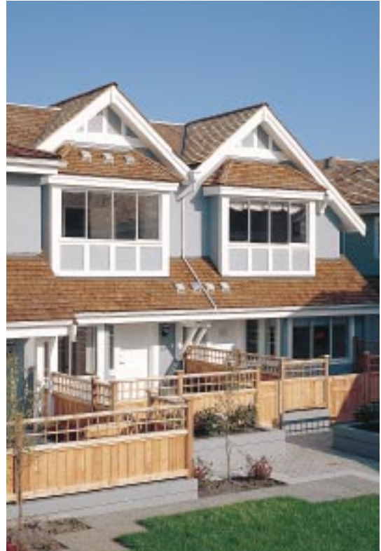
屋根にシダー・シングル、外壁にシダー・サイディングを使用。ウェスタン・レッド・シダーが耐久性・耐候性に優れていることを利用した独特の使用例です。フェンスにも使用されています。
